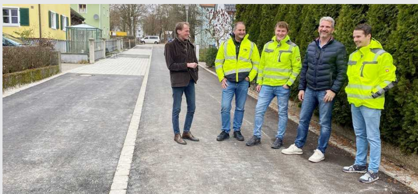
Beim Pressetermin der Baustelle in der Johann-Matthäus-Metzger-Straße: OB Dr. Hammer, Bauleiter Bernd Andörfer von der Firma Ernst Hähnlein Bau, Jannik Sindel von den Stadtwerken und Werkleiter Andreas Karl. Für Richard Dürr war es die erste Baustelle als Wassermeister bei den Stadtwerken
